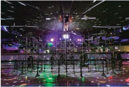
照明「LANTERNA」（4面サイネージ）× 14台のほか、首振りのムービングライト× 24台、ゴボライト× 6台、スポットライト× 3台を配置。プロジェクターで斜め下のローラースケートリンク床面に映像を投影し、等間隔にある「LANTERNA」同士が連携して同じタイミングで切り替わる映像に合わせて、スポットライトがミラーボールに光を照射する。音響は既設のスピーカーシステムを採用した。〈会場の様々な制約もありつつ、音響と照明の組み合わせによって人が集まりやすいような空間にするため、一番目に付くセンターに力強いものを置くのがポイントだと考えました〉と神田氏。
