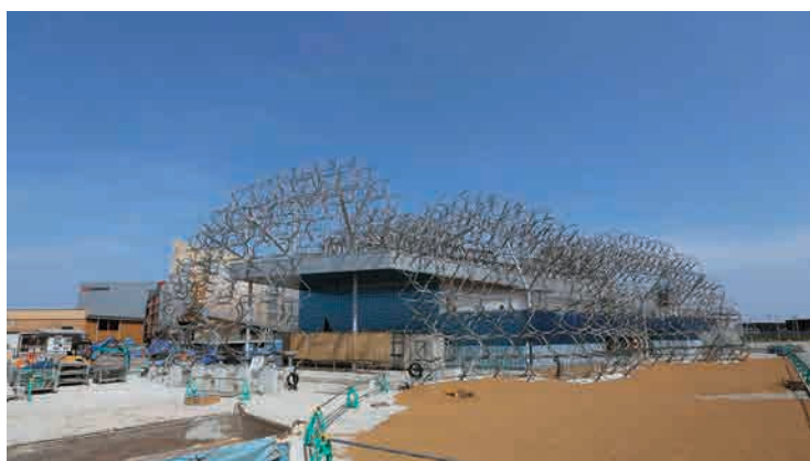
「長期タイムラプス撮影サービス」で制作された大阪・関西万博 パナソニックパビリオンの建設の記録
